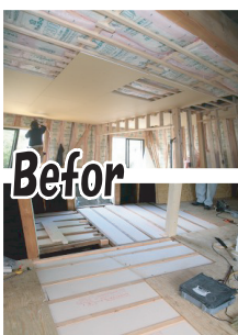
壁断熱 天井断熱
